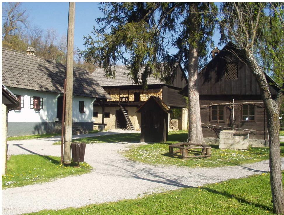
Sl. 9. Obnovljena zadružna okućnica (Izvor: Fototeka MSS)
