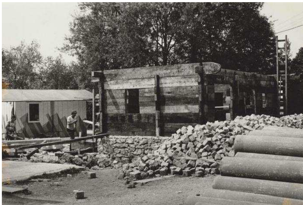
Sl. 4. Gradnja zidnih stijena "hiže mazanke" (Izvor: Fototeka MSS)
