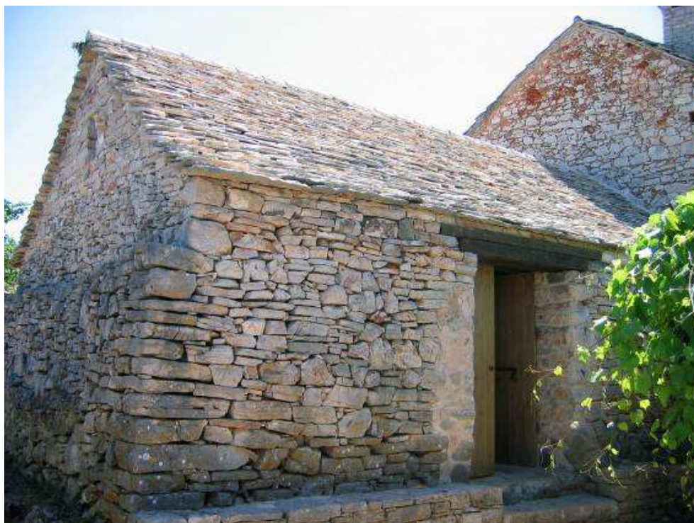
Sl. 12: Gospodarska kućica nakon obnove – današnja etno-zbirka (foto: S. Buble, 2009.)
