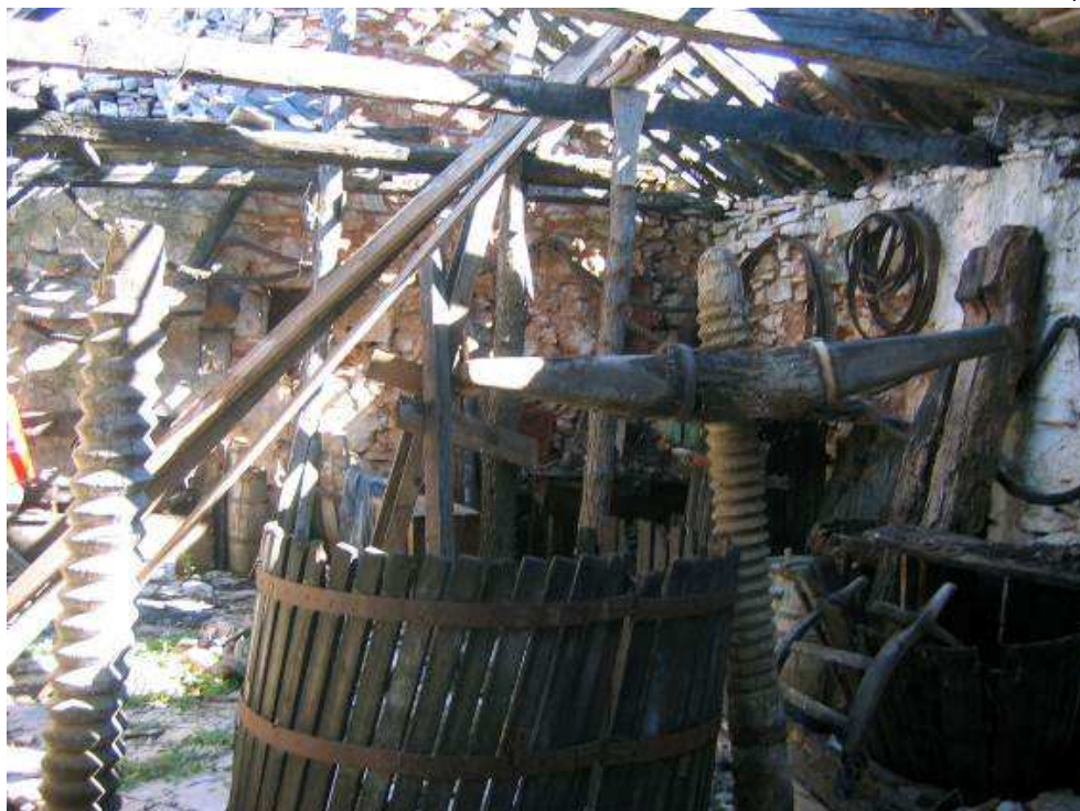
Sl. 11: Ruševna gospodarska kućica prije obnove – unutrašnjost s djelomično sačuvanim turnjem (foto: S. Buble, 2008.)
